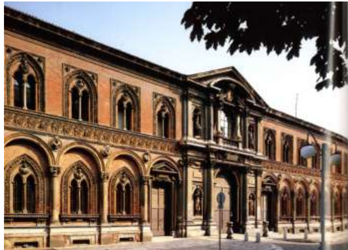
Ilustración 77. Fachada del Hospital de Milán.
