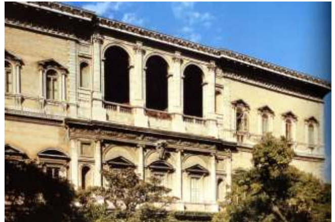
Ilustración 140. Fachada trasera del Palacio Farnesio.
