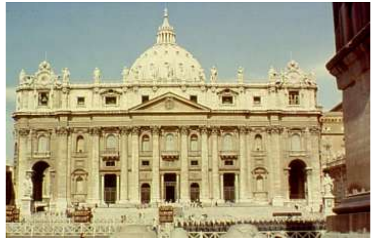
Ilustración 168. Fachada de San Pedro.
