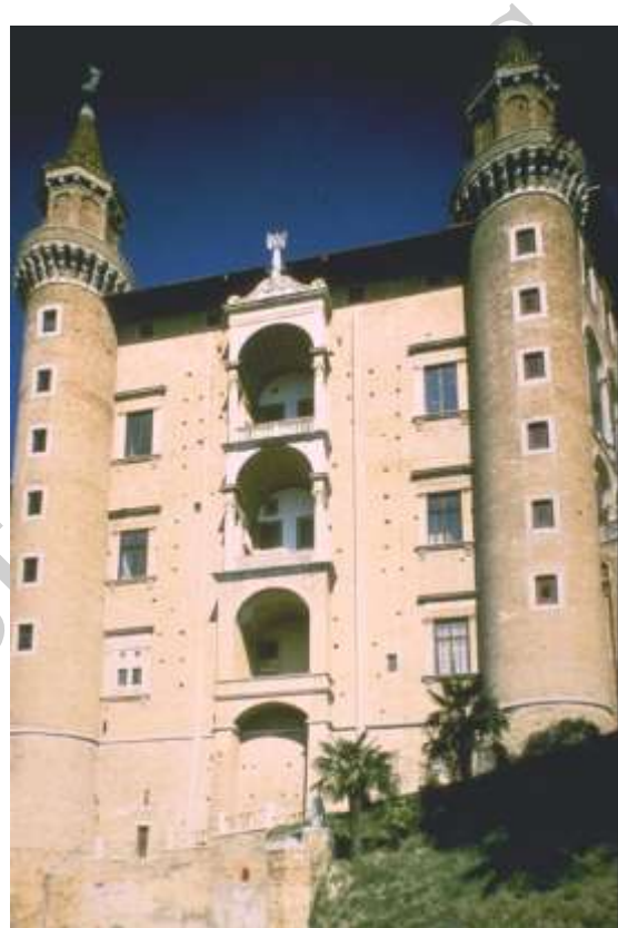
Ilustración 73. Fachada del castillo.
