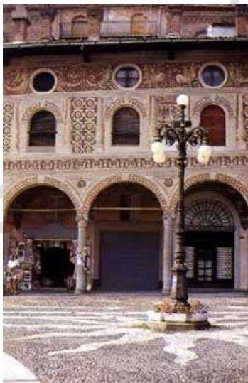
Ilustración 110. Detalle de los arcos.
