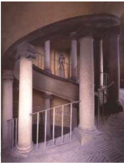
Ilustración 119. Escalera helicoidal del Belvedere.
